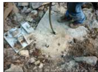
Zwei verschiedene Formen der Verankerung am Schutzzaun.
