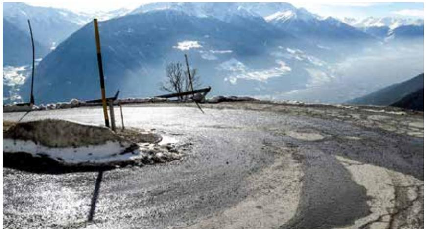
**Ein aktuelles Projekt. Im Bild die Kehre bei den KaserHöfen kurz vor St. Martin im Kofel. Gut zu erkennen, der desolater Zustand der moroden hölzernen Leitplanken, wobei diese direkt in der Kehre fehlen.**
