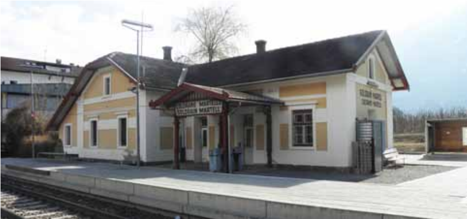
Am Bahnhofsgelände in Goldrain besteht seit Jahren Handlungsbedarf
